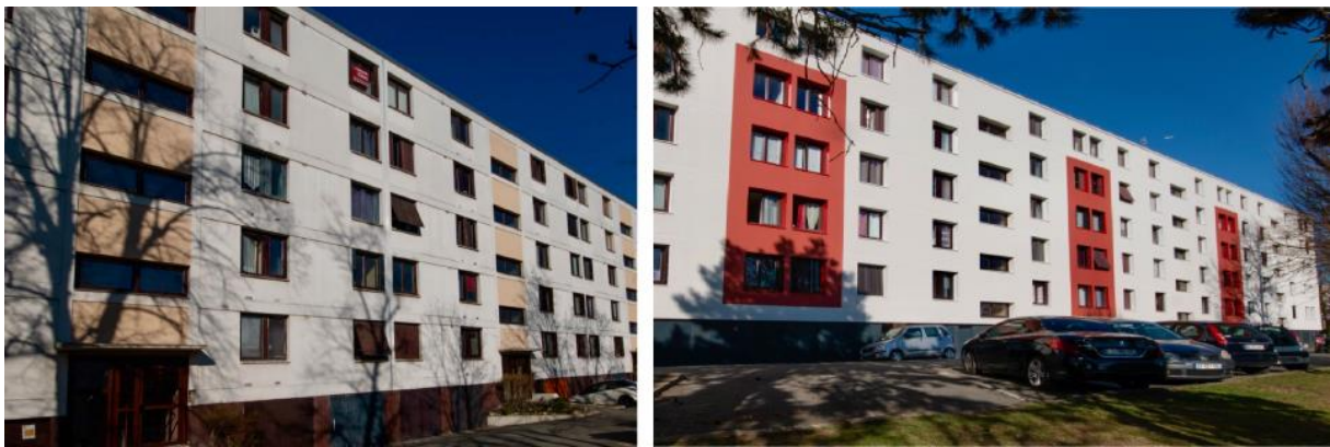
Un des bâtiments du site de Franconville avant et après travaux
